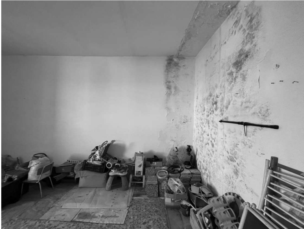
Camera da letto : materiale di risulta accatastato del solaio della zona cucina pranzo.
